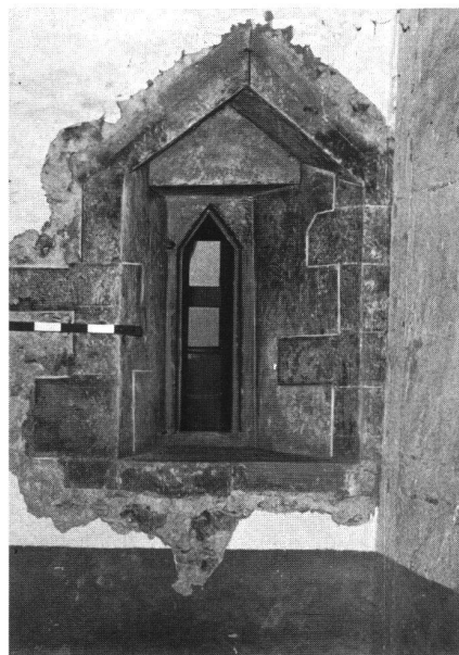
Kappel. Giebelfenster des Obergeschosses von innen.
