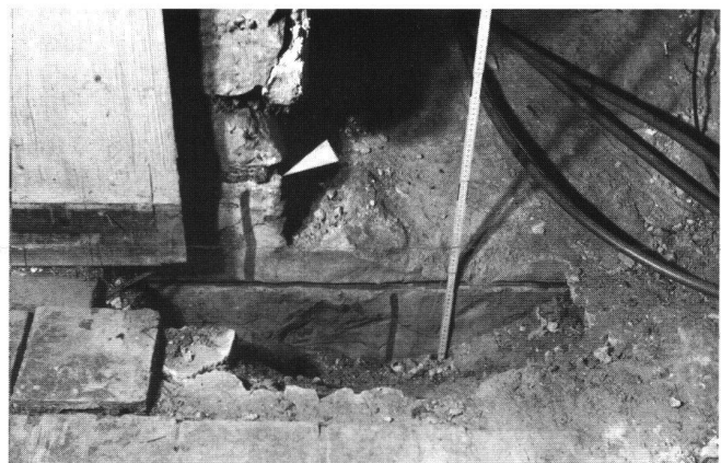
Nordfassade, hinter dem späteren Spitztonnengewölbe der SS. Simon und Judas-kapelle. Dieses Bild zeigt die Dachhöhe (Pfeil) des ehemaligen «Einsiedlerhauses». Darauf setzt die Aufstockung der 3. Bauetappe an.
