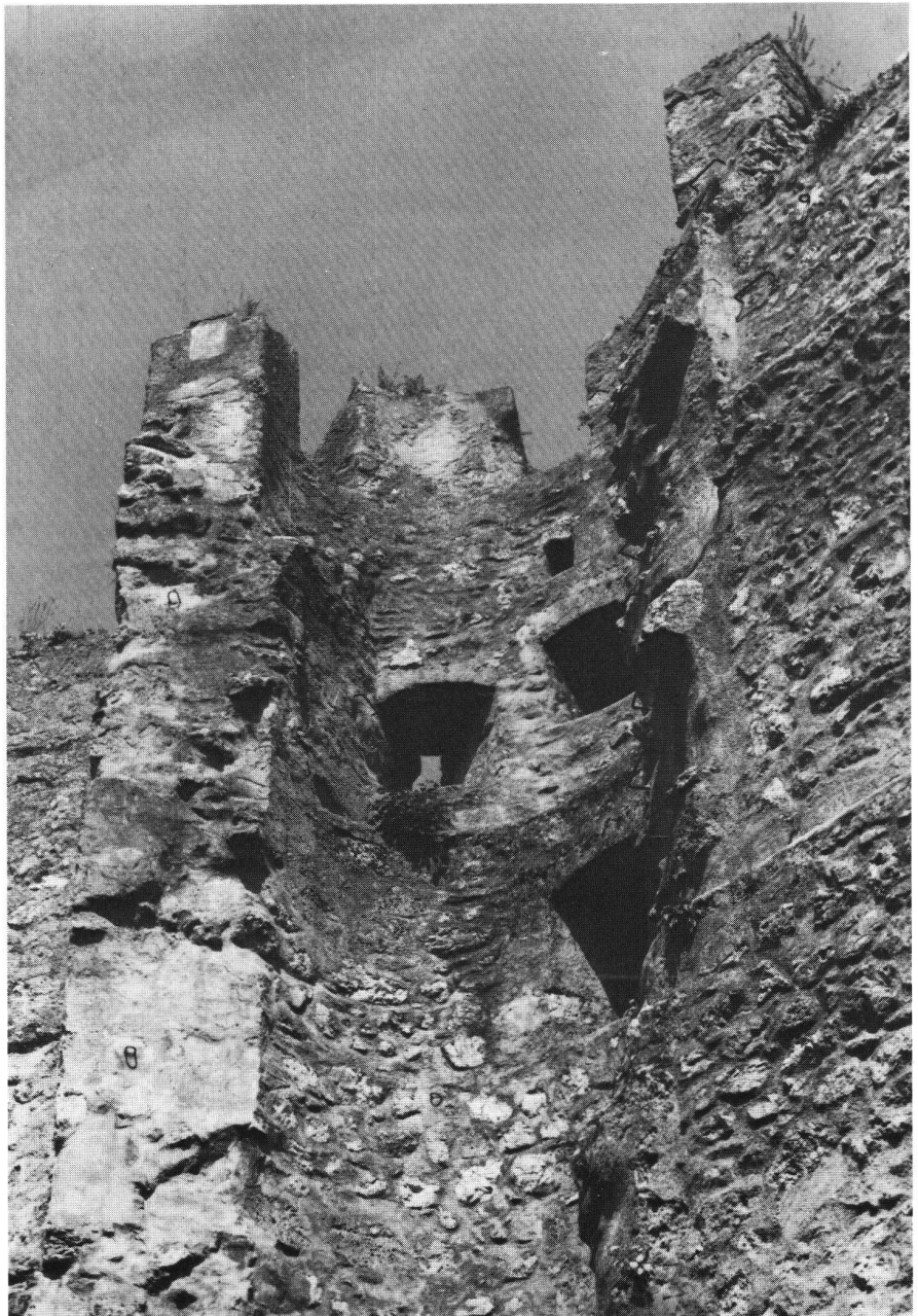
Neu-Thierstein, Inneres des Wohnturmes mit der äusseren Halbschale des Rundturmes. Zustand von 1984.
