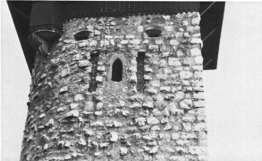
Niedergösgen SO, Burg-/Kirchturm, Oberteil der Nordfassade.
