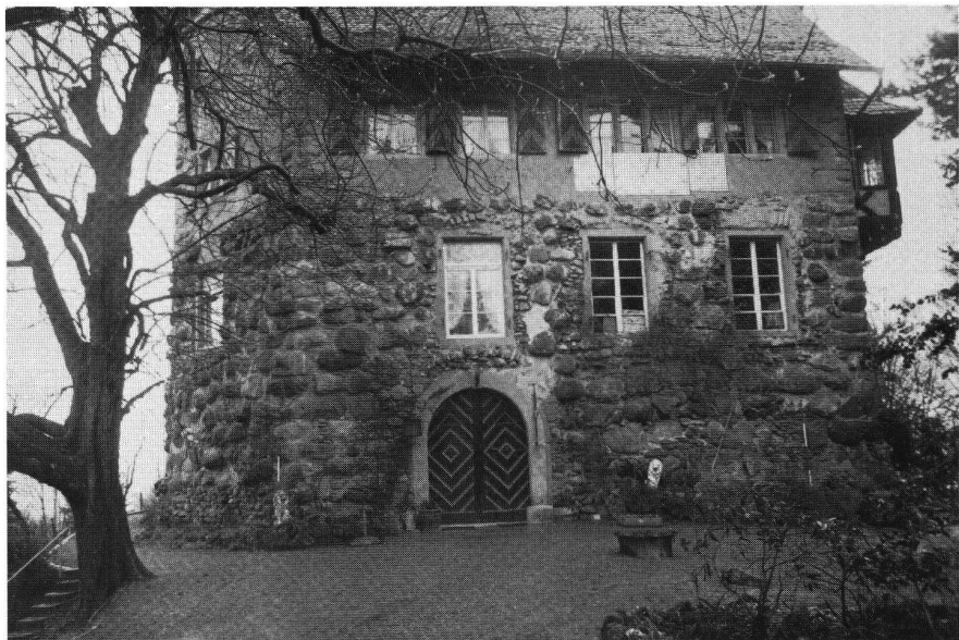
Wellenberg TG, südliche Schildmauer/ Fassade.
