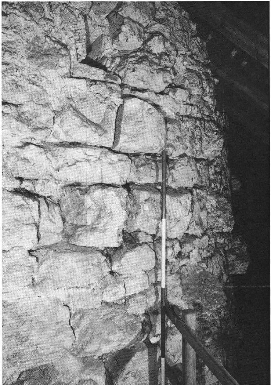
Schloss Zwingen, Ausschnitt von der SE-Seite des Turmes, im jetzigen Dachraum des Palas.
