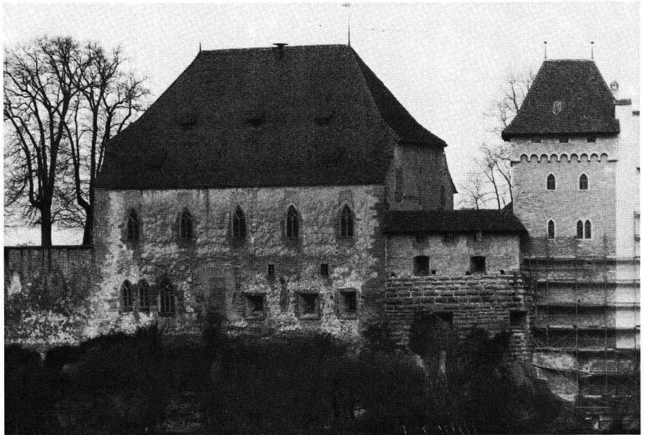
Das Ritterhaus vor der Restaurierung.
