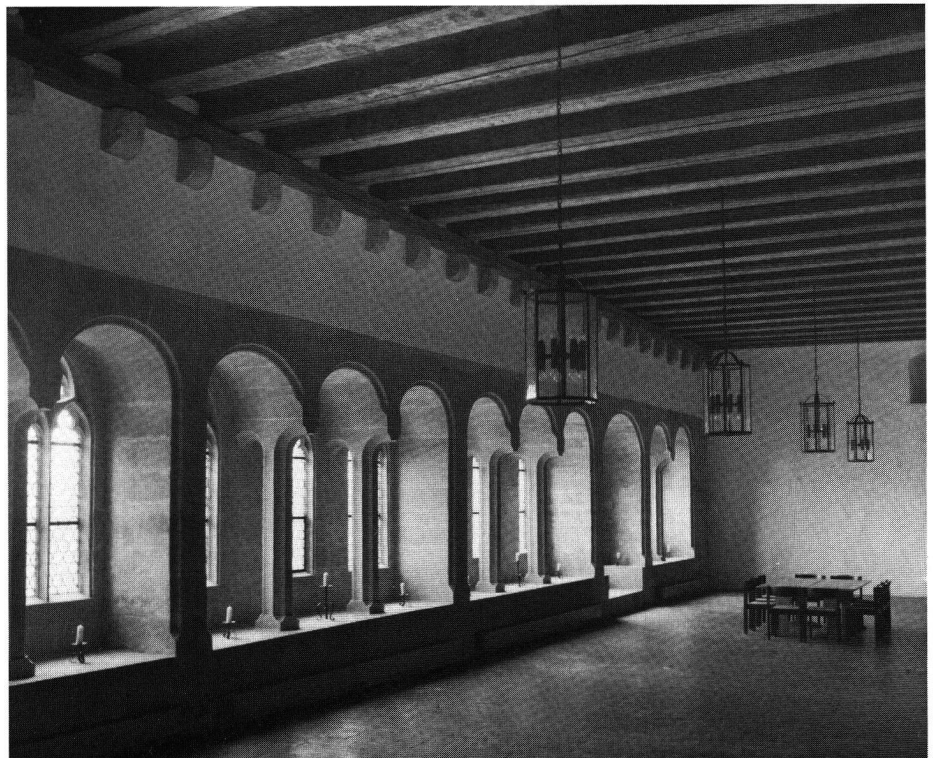
Ritterhaus, Blick in den unteren Saal nach erfolgter Rekonstruktion des gotischen Fensterbandes.
