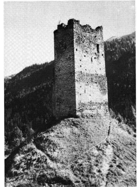
Strassberg GR. Hauptburg mit Turm von SW.
