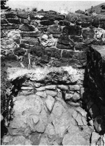
Schnitt S1, Blick gegen N. Inneres Haupt der Ringmauer. Der Massstab steht auf modernem Zementfuss. Darunter originales Mauerwerk. Obere Mauerteile rekonstruiert.
