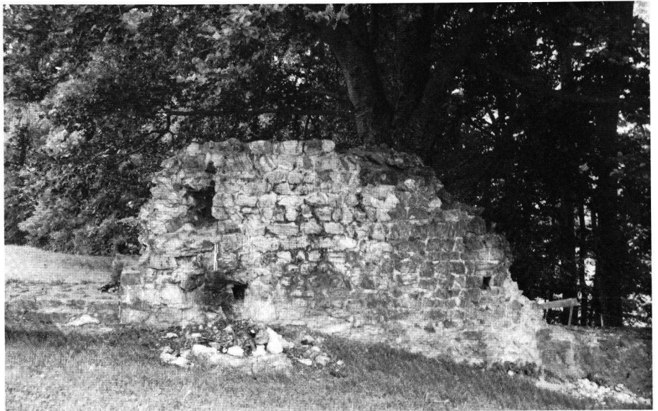
Ringmauer, NW-Partie. Inneres Mauerhaupt mit Gerüstbebellöchern.
