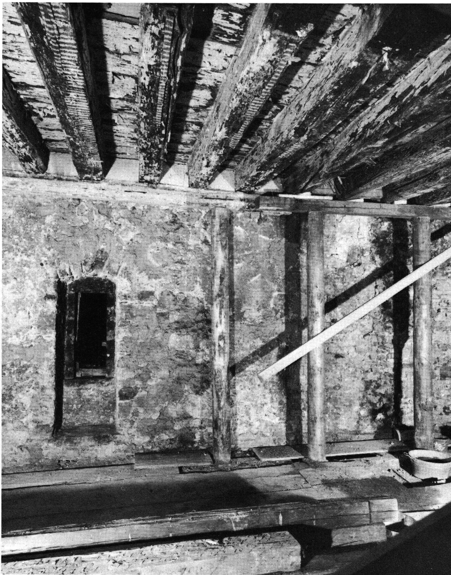
Abb.21: «Glentnerturm», Innenansicht an das Fenster im 3. Obergeschoss der Ostfassade. Unregelmässig dicht sind die mittelalterlichen Geschossbalken direkt ins Mauerwerk verlegt.
