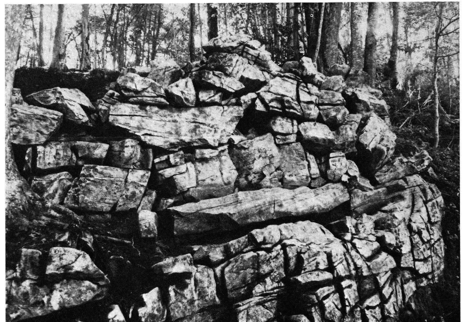
Illgau/ Balmis 1987, Gebäude 1, östliche Aussenmauer über natürlichem Felsband, Ansicht von Südosten.
