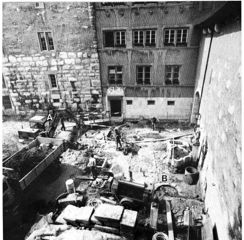
Die Sanierungsarbeiten im Schloss förderten von 1985 bis 1987 eine archäologische Überraschung nach der andern ans Tageslicht. Im mittelalterlichen Hof stand städtchenwärts einst der Palas; zwischen ihm und dem Bossenquaderturm des 13. Jb. fanden sich gleich zwei Sodbrunnen (A, B).
