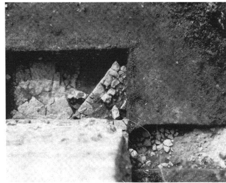
Photo 8 Tour de Milandre, angle sud. Dégagement des fondations, sondage archéologique de 1987.
