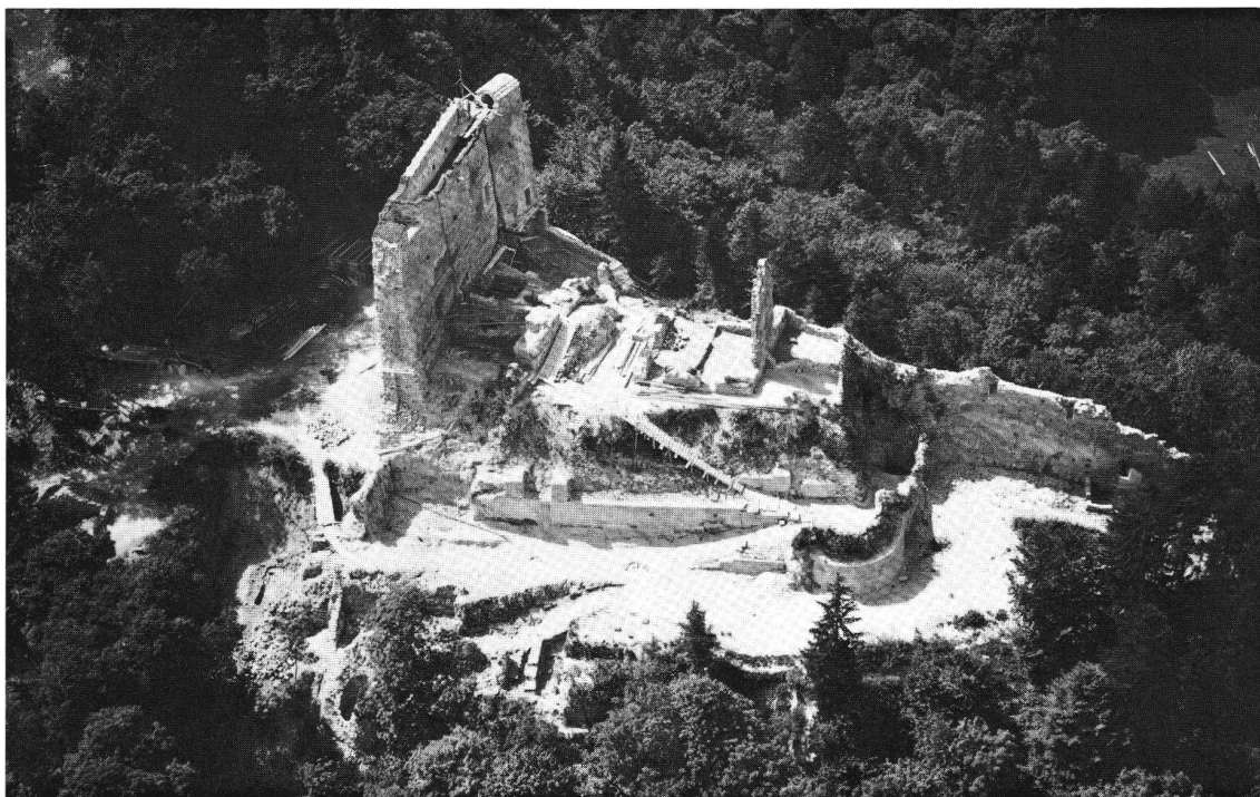
Farnsburg BL, Luftaufnahme während den Restaurierungsarbeiten um 1931.
