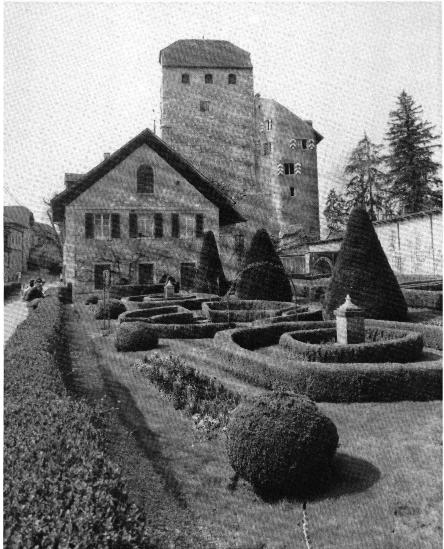
Möriken AG, Wildeggen, Burgturm mit jüngeren Anbauten und Nebengebäuden
