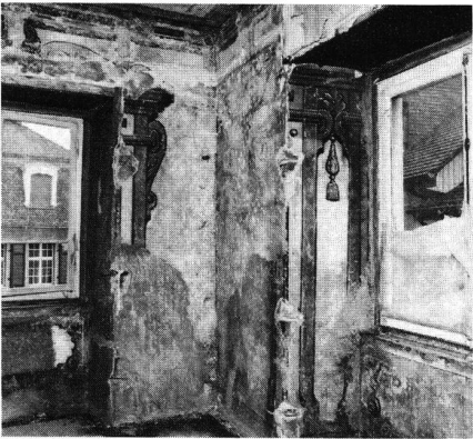
8 Rennweg 1, «Grosser Widder». Geschützt durch Wandtäfer haben sich im 3. Obergeschoss Malereien des ehemaligen Zunfssaales erhalten. Die ältere Fassung entstand mit dem Neubau von 1533, die jüngere 1678, als die Decke dieses Raumes 30 cm höher gelegt wurde.
