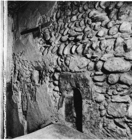
13 Rennweg 5, «Pfeife». Sekundär eingebautes romanisches Fenster in der Westwand des um 1200 erbauten Kernbaus.
