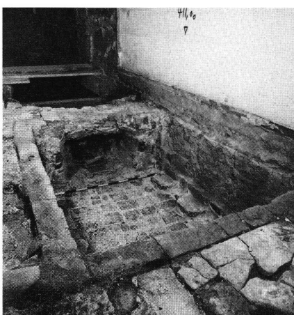
5 Augustinergasse 46. Der im «namenlosen» Haus entdeckte und freigelegte Feuerkasten eines Töpferofens aus dem mittleren 16. Jahrhundert wurde sorgfältig dokumentiert und wieder zugedeckt.
