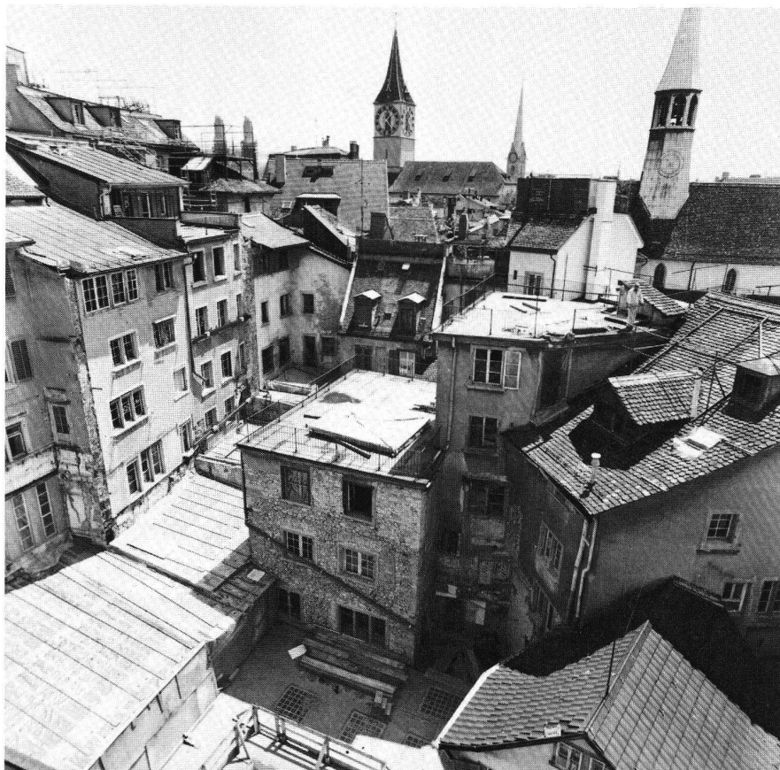
3 Blick von der Hofseite auf die Häuser am oberen Rennweg, der Widder- und der Augustinergasse, welche im Hinblick auf die geplante Neunutzung als Hotel baugeschichtlich untersucht werden konnten.
