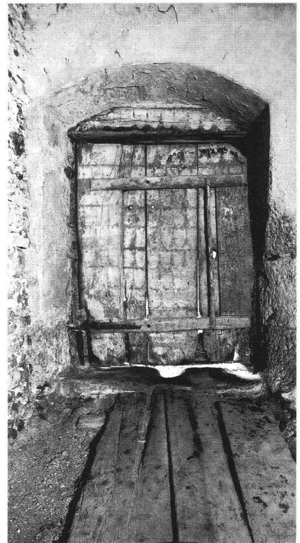
Palas von 1318. Unterer Saal: Portal in der Süd-wand mit originale Türblatt. Es dreht sich oben noch mit einem herausgeschnitzten Drehzapfen im Drehloch des Sturzbalkens. Über Sturz und Türblatt zieht der Fehbesatz.
