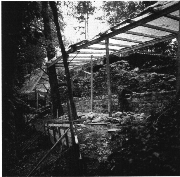
Abb. 11 Konservierungsarbeiten an der Mauer M 1.
