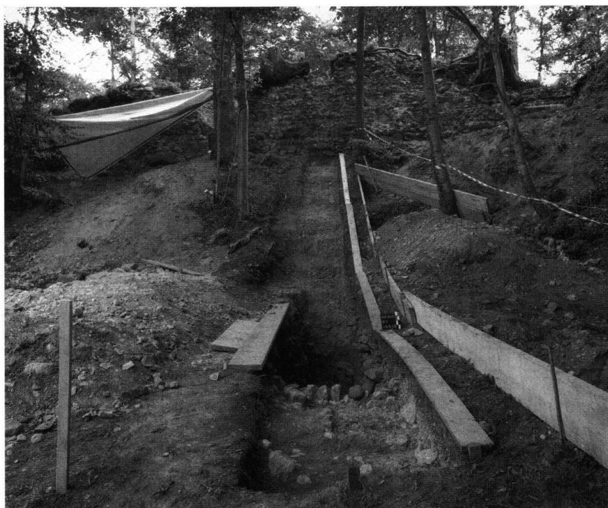
Abb. 3 Die Aufnahme zeigt den auf der Südseite des Hügels liegenden Teil des Sondiergrabens. Im Vordergrund sind der Seitengraben und die Abbruchkronen der Grabenfütermauer (M 3) zu erkennen. Der linke der beiden grossen Wurzelstöcke auf der im Hintergrund sichtbaren Mauer M 1 ist mindestens 150 Jahre alt.
