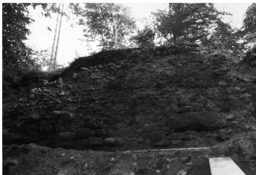
Abb. 8 Westlicher Teil der Mauer M 1. Im Fundamentbereich liegt ein grosser Findling; die Steine im Mauerkern sind sehr regelmässig.
