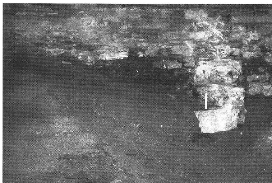
Abb. 12 Nördlicher Stadtgraben im Kirchgemeindehaus an der Pfrundhausgasse mit einer jüngeren, in den aufgefüllten Graben fundierten Gebäudemauer. Blick nach Westen.
