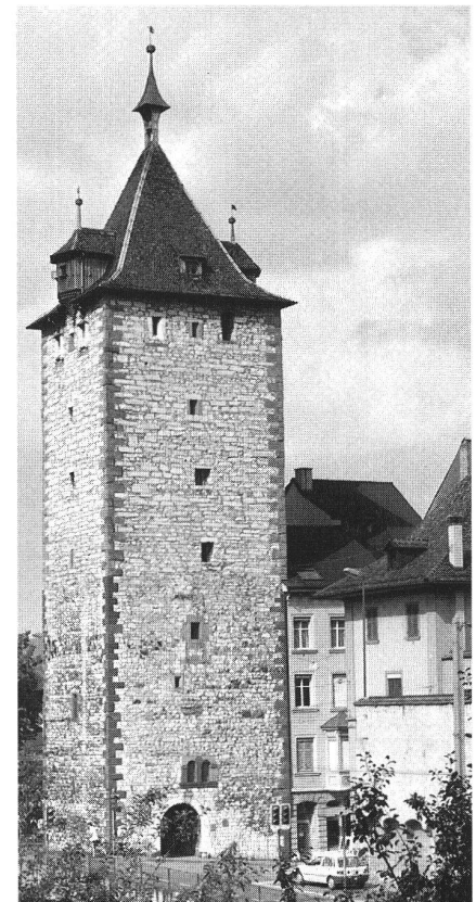
Abb. 2 Der Obertorturm, im späteren 12. Jahrhundert als Wohnturm erbaut; 1491 von der Stadt um die obere Hälfte aufgestockt. Rechts teilweise verdeckt von der jüngeren Stadtmauer das Oberhaus. Möglicherweise lag hier eine allfällige Stadtburg der Nellenburger beziehungsweise die 1098 erwähnte Burg des Vogtes.
