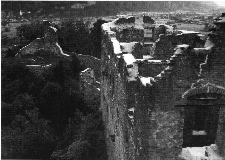
Blick ins Seeztal (Südosten): Aufnahme nach der Sanierung, September 1991. (Foto IGA, EAD)
