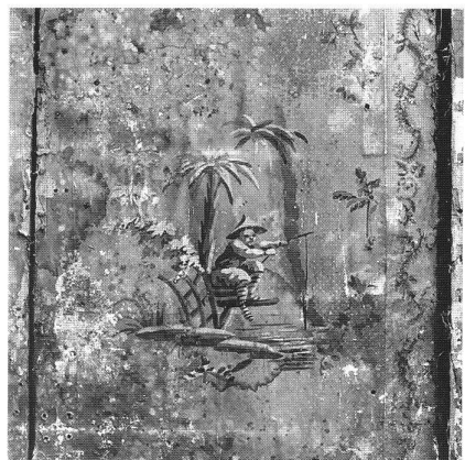
34: Chinoiserietapete in der «Teestube» des ersten Obergeschosses Südosteckzimmer, 1762.
