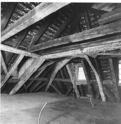
32: Walmdachstuhl im «Hinteren Schwert-Turm», 1762.
