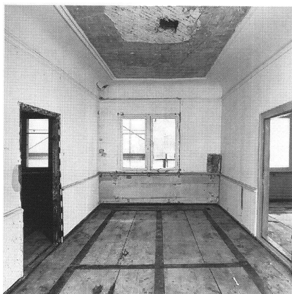
33: Suite mit Seesicht im 3. Obergeschoss, 1762.
