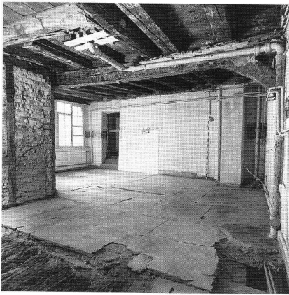
37: «Hotchküche» von 1762 im Hofüberbau zwischen den beiden Türmen.
