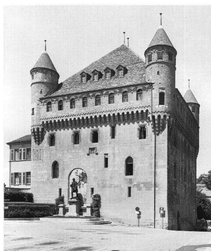
2: Château St-Maire. Construit entre 1397 et 1427 par l'évêque. Son couronnement en brique témoigne de l'intervention de maçons du nord de l'Italie au début du XV e siècle. – Zwischen 1397 und 1427 vom Bischof erbaut. Sein Maschikulkranz aus Backstein zeigt den Einfluss piemontesischer Baukunst seit dem Beginn des 15. Jhs.
