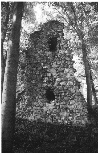
4: Neu-Habsburg/Meggen LU. Mauerrest eines Rundturmes.
