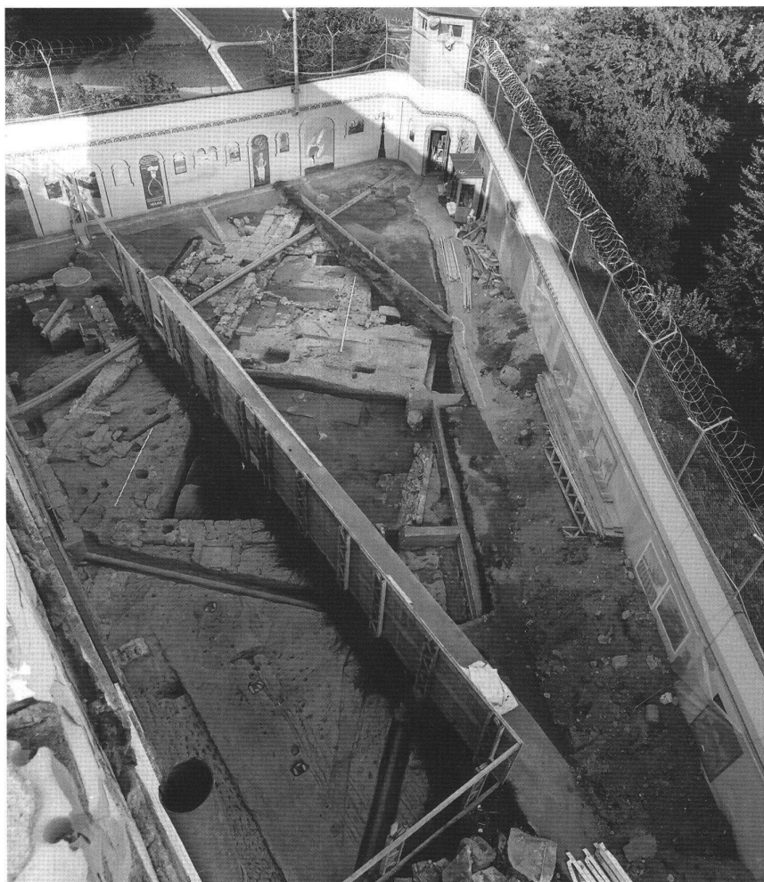
9: Westteil der Grabung, Blickrichtung Süd. Links sind die Grundmauern des Kreuzgangflügels zu erkennen; links davon die Reste der Zelle Nr. 3, rechts davon von vorne nach hinten die Zelle Nr. 6, der Garten 5 b, die Zellen Nr. 5 und Nr. 4.
