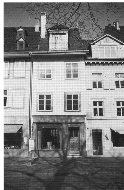
8: Strassenfassade des Hauses nach der Restaurierung.
