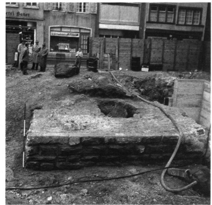
2: Fundament des 1957 im Storchenareal freigelegten namenlosen Wehrturms (heute Stadtbaugasse 21).
