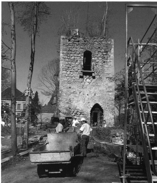
6: Der Turm von Osten, während der Vorbereitungsarbeiten für die Sanierung 2007.
