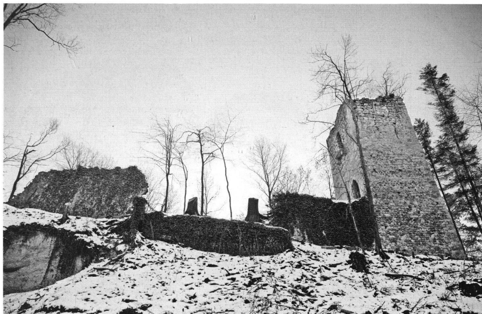
5: Blick vom Fuss des Turmes nach Süden, vor der Sanierung, Januar 2007.
