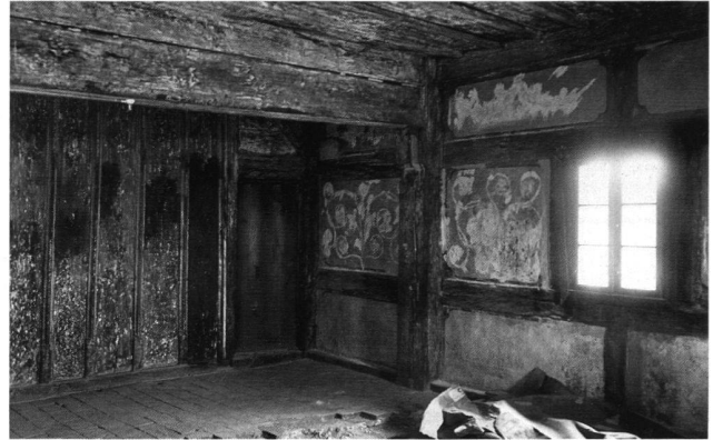
14: Die mit dem Riegelobergaden verbundene Holztäferwand mit gotisch profilierten Leisten im südwestlichen Zimmer, zweites Obergeschoss. Auf den Riegelfeldern wurde eine Rankenmalerei angebracht. Fotografie 1936.
