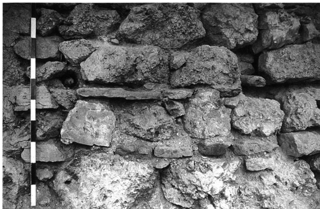
6: Arlesheim-Birseck, Detail der Südfassade, Bauphase 1 (Lütholdbau, um 1243/44). Über einer horizontalen Baufuge (Winterpause?) liegen zwei original erhaltene Gerüsthebel aus der Bauzeit. Gut erkennbar sind die unförmigen Bruchsteine aus dem örtlichen Korallenkalk. Der Fugenmörtel ist stark ausgewittert.
