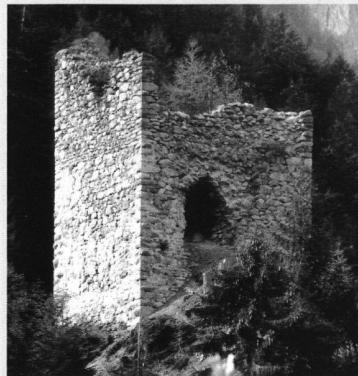
Reischen I vor den Substanzverlusten von 2001. Ansicht von NO.
