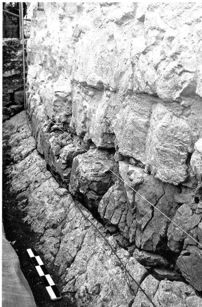
5: Fundamentzone am südwestlichen Fuss der Schildmauerfassade, von Südosten.
