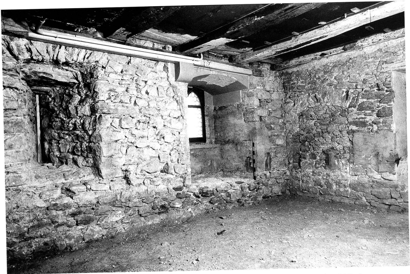
5: Schloss St. Andreas. Erdgeschoss, Räume 0.16 und 0.17. Ansicht an die Mantelmauer mit originalem Schlitzfenster und die südliche Gebäudemauer mit zugemauelter Türöffnung. Foto 2010.
