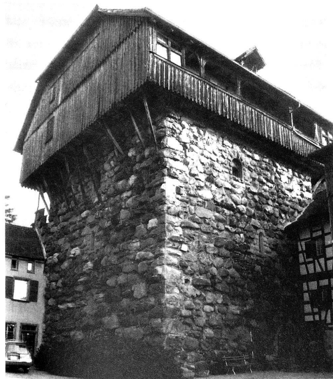
4: Die nahe mit dem Turm von Richensee verwandte Burg von Mammertshofen TG trägt noch heute einen mächtigen, spätgotischen Obergaden.
