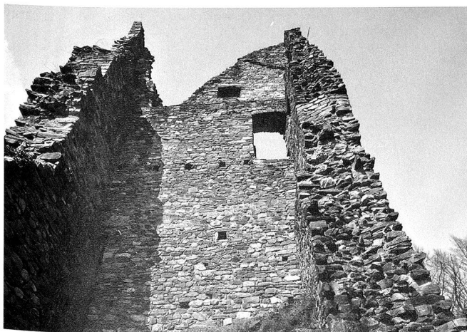
4: Der viergeschossige Wohnturm, Sicht von Süden.
