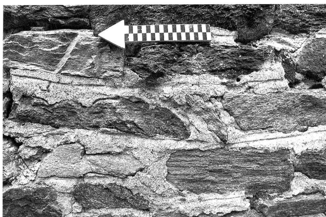
3: Pietra-rasa-Verputz mit Fugenstrich an der Umfassungsmauer der Phase 1.
