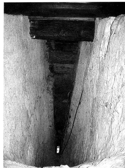
4: Fenster im zweiten Obergeschoss des Kernbaus, in Phase 3 als Scharfe nach aussen verlängert. Dendrodaten liegen bislang nur von den in Phase 3 eingesetzten Sturzbrettern vor. Foto: Werner Wild, Kantonsarchäologie Zürich.
