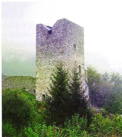
2: Der Wohnturm von Jörgenberg, Waltensburg, mit der sehr diskreten Blecheinfassung der Turmkrone (Foto BVG).
