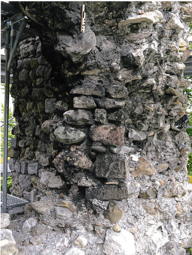
5: Schänis SG, Ruine Niederwindegg, 2020. Mauer M2, Öffnung 3. Rest der nordwestlichen Leibung der sich ehemals trichterförmig gegen aussen erweiternden Öffnung, von Osten.
