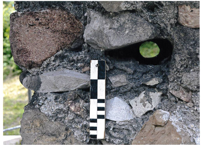
13: Schänis SG, Ruine Niederwindegg, 2020. Mauer M2, Aussenfassade. In seiner Zusammensetzung an Beton erinnernder Mörtel rund um das Gerüsthebelloch 1.3 (ausser), von Nordosten.
