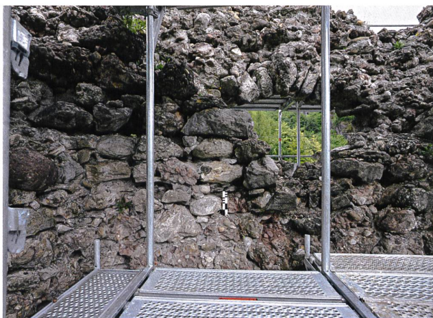
20: Schänis SG, Ruine Niederwindegg, 2020. Mauer M2. Der Mauerinnenmantel im Bereich der Öffnung 5 besteht mehrheitlich aus roter Nagelfluh, von Südwesten. Der rote Stein am linken Bildrand ist ein Geröll aus Verrucano-Gestein.
