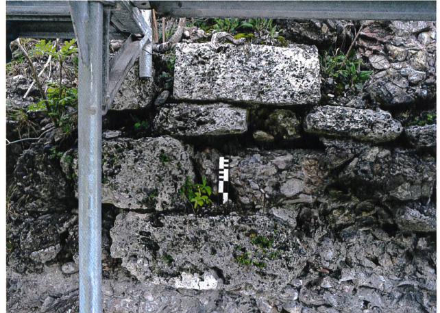
12: Schänis SG, Ruine Niederwindegg, 2020. Mauer M2. Mauerpartie in der Aussenfassade mit Einlagen aus nicht bossierten Tuffsteinquadern anschliessend an die nordwestliche Leibung der Öffnung 4, von Nordosten.
