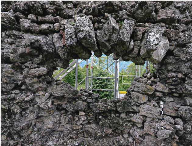
14: Schänis SG, Ruine Niederwindegg, 2020. Mauer M2, Aussenfassade. Rest des aus verschiedenen Steinsorten zusammengesetzten Stichbogens über der Öffnung 5, von Nordosten.
