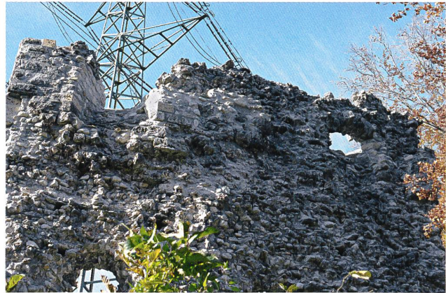
19: Schänis SG, Ruine Niederwindegg, 2020. Mauer M2, oberer Teil der Aussenfassade mit den Öffnungen 4 und 5 nach Abschluss der Sanierungsarbeiten, von Nordosten. Die Aufnahme macht deutlich, dass ein am Standort des Fotografen stehender Angreifer problemlos aus der Öffnung 4 beschossen werden konnte.
