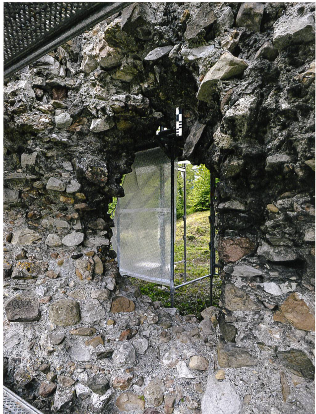
6: Schänis SG, Ruine Niederwindegg, 2020. Mauer M2. Blick auf die Aussenseite der Öffnung 3, von Norden. Rechts neben dem Massstab steckt im Kernmauerwerk noch ein letzter Stein des ausgebrochenen Stichbogens.
