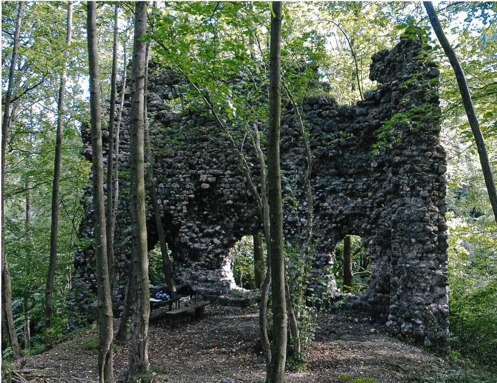
2: Schänis SG, Ruine Niederwindegg, 2020. Mauern des im Bericht als Windegg 2 bezeichneten Gebäudekomplexes vor dem Roden der gesamten Burganlage im Winter 2016/17. Aufnahme aus dem Jahr 2012, von Südwesten.
