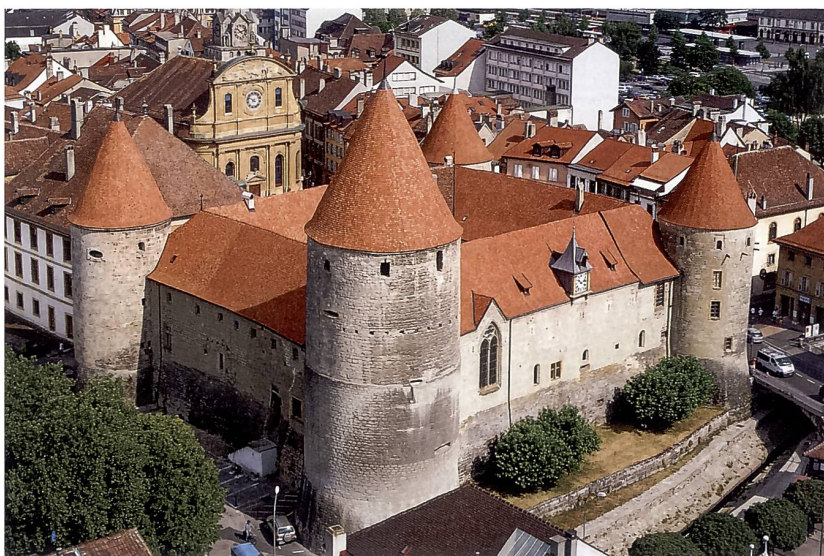
Schloss Yverdon VD, eine savoyische Kastellburg aus dem dritten Viertel des 13. Jh. mit dem «grand tour» im Vordergrund (Foto Rémy Gindroz).
