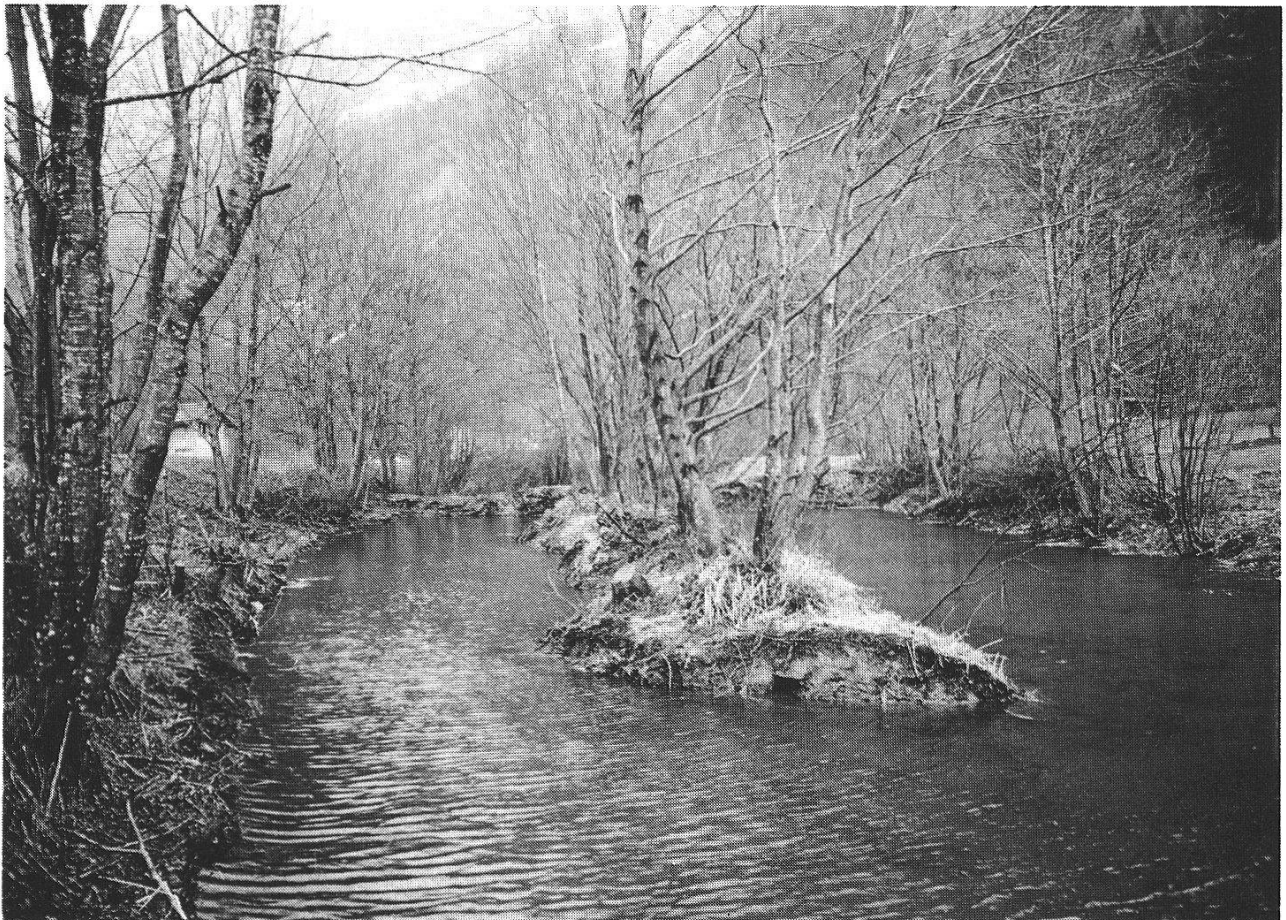
Abb. 3: Die Jägglisglunte, der Altlauf der Aare bei Brienz, war vor der Sanierung fast vollständig verlandet und die Bestockung war so dicht, dass fast kein Licht bis zum Wasser drang.
