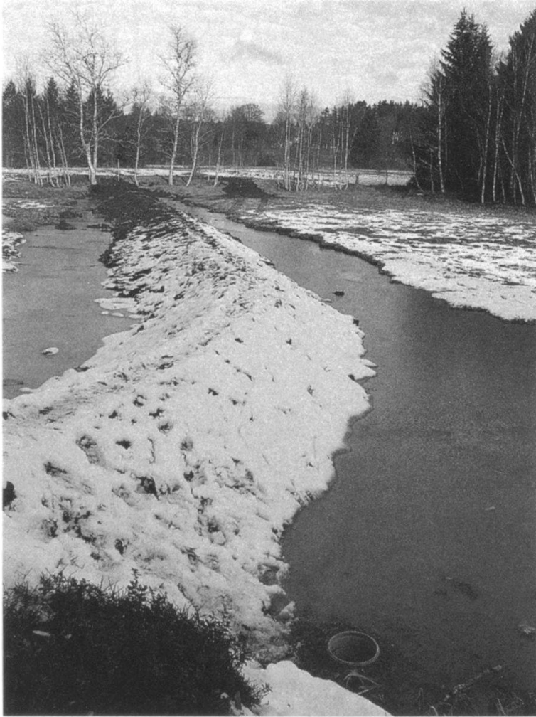
Figure 3: La nouvelle digue à l'ouest de la plaine centrale (Photo Fr. Gfeller, 4.12.1995).
