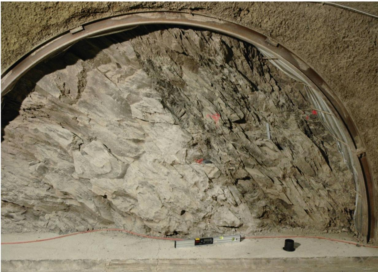
**Abb. 3:** Aufschluss des Opalinustons unter einem Stahlbogen im Felslabor Mont Terri (JU). Links (heller) ist das Gestein wenig bis gar nicht deformiert, rechts (dunkler) ist eine grosse,  $45^\circ$  nach rechts einfallende Bruchzone erkennbar. Bildbreite ca. 3 m.
