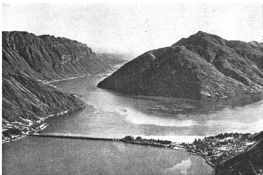
Le pont de Melide
