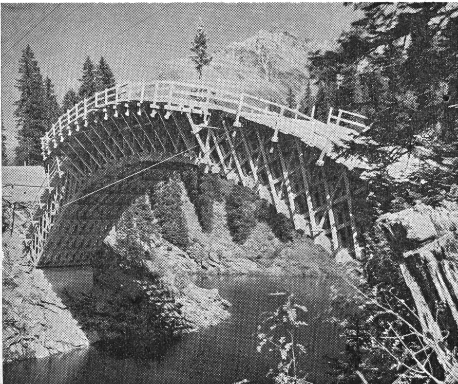
Coffrage d'un pont moderne dans les montagnes. « Le bois est à l'origine de toute construction — dont le charpentier assure l'exécution. »
