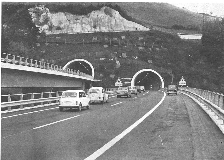
Autoroute du Léman : entrée ouest des tunnels de Chexbres.
