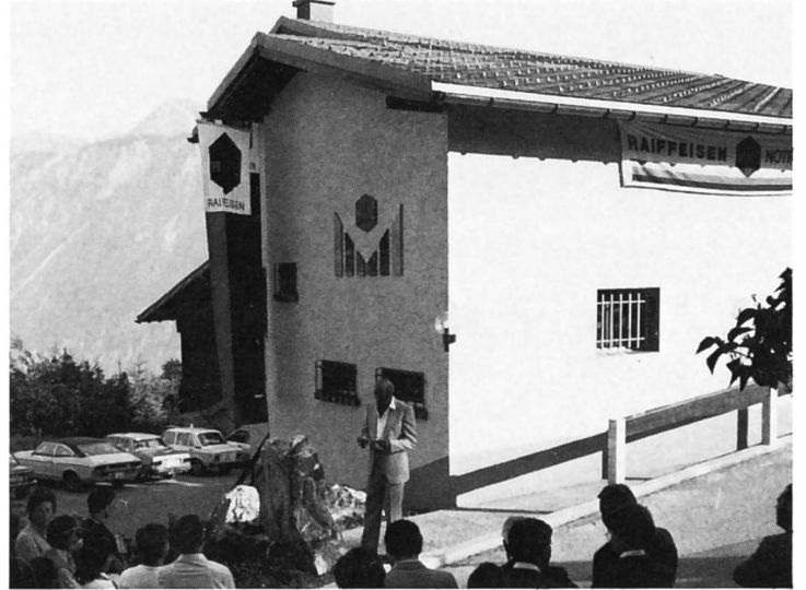
Le nouvel immeuble de la Caisse Raiffeisen de Mollens.
