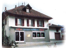
Des locaux confortables, à fleur de trottoir, dont les habitants de Broc vont pouvoir profiter. Par dessus tout, c'est une prestation bancaire de pointe et une grande palette de produits qui viennent combler les attente de la population.
