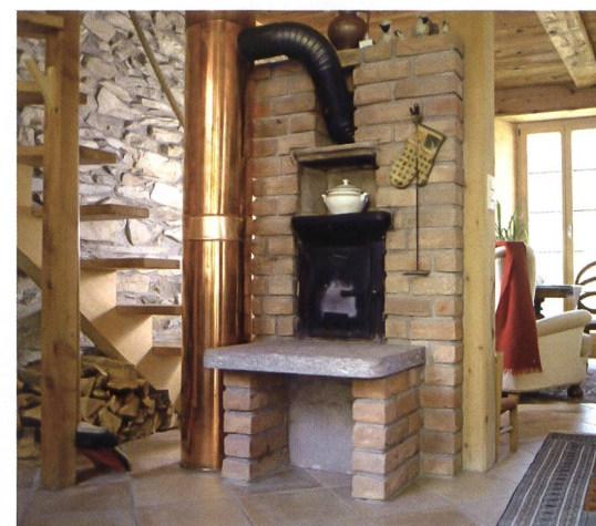
L'escalier a été fait à partir d'anciennes pièces de bois. Bouche en brique sur la paroi arrière du four.
