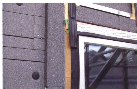
Un soin tout particulier a été apporté à l'isolation des fenêtres affleurées en façade, afin d'obtenir le meilleur rendement énergétique.
