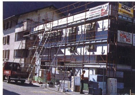
L'isolation en façade atteint 24 centimètres d'épaisseur.
