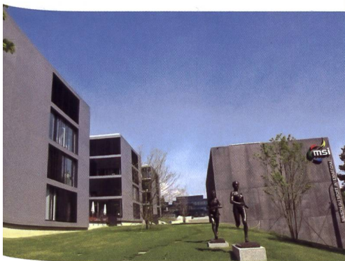
Avec la construction de la Maison du sport, plusieurs fédérations internationales sont venues s'installer à Lausanne confirmant ainsi son statut de «capitale olympique et du sport».
