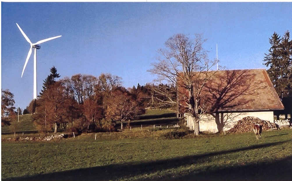
Une éolienne au milieu des pâturages du Mont-Soleil.
