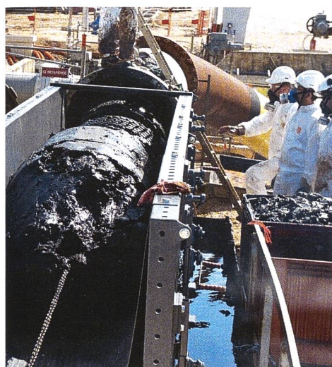
L'outil de nettoyage sorti d'une imposante conduite.
