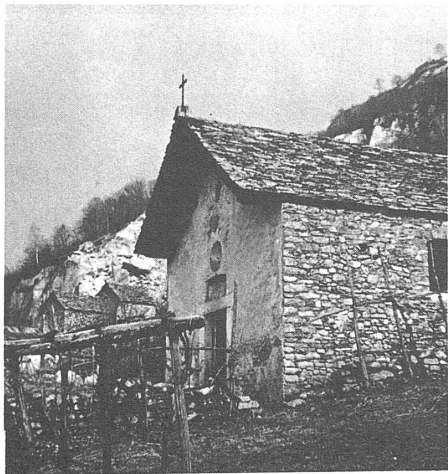
Cresciano al Sasso: la Chiesa, originariamente di S. Maria, venne ribattezzata in Chiesa di S. Carlo prima ancora del 1610, anno in cui il Borromeo venne ufficialmente proclamato santo.
