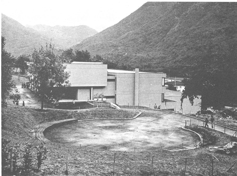
Veduta del centro scolastico per i Comuni di Mezzovico-Vira, Camignolo e Sigirino con il posto destinato alla realizzazione dell'anfiteatro per le lezioni all'aperto.
