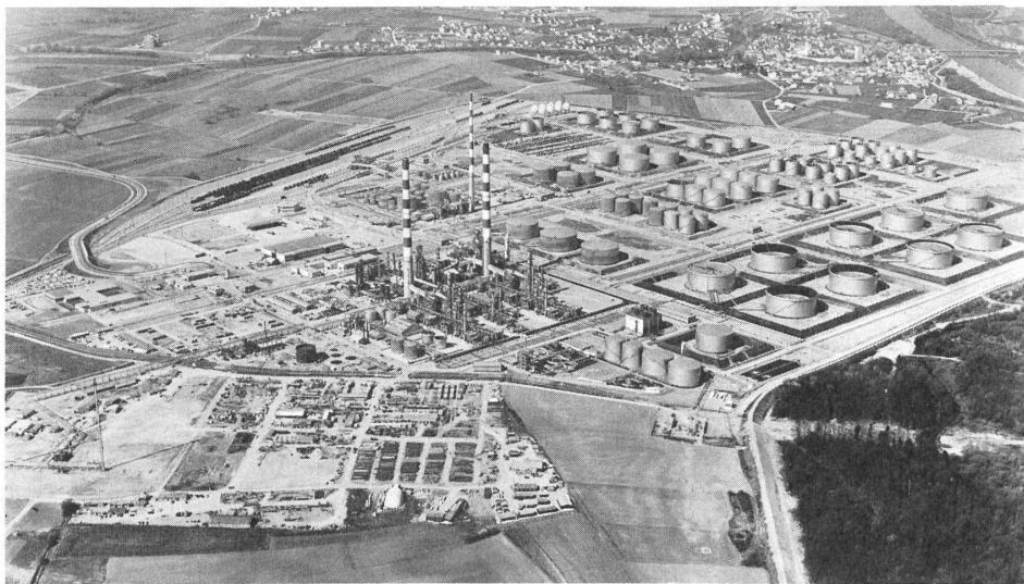
Veduta di una raffineria. Nelle vicinanze di ogni raffineria c'è una vasta zona coperta di grandi cassoni argentei: è il parco serbatoi, che riceve il petrolio greggio e lo immagazzina in attesa che i raffinatori siano pronti a lavorarlo. Dall'unica materia prima immessa in questi serbatoi si ottengono più di mille diversi prodotti.
